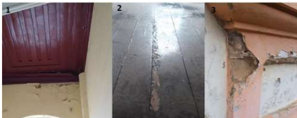
Figura 3: Forro de madeira (1), assoalho de madeira (2), detalhes da fachada (3). Fonte: Acervo Pessoal, 31/03/2022.
