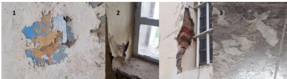
Figura 2: Parede externa (1), janela parte interna/externa (2), piso de Ardósia cinza (3).
