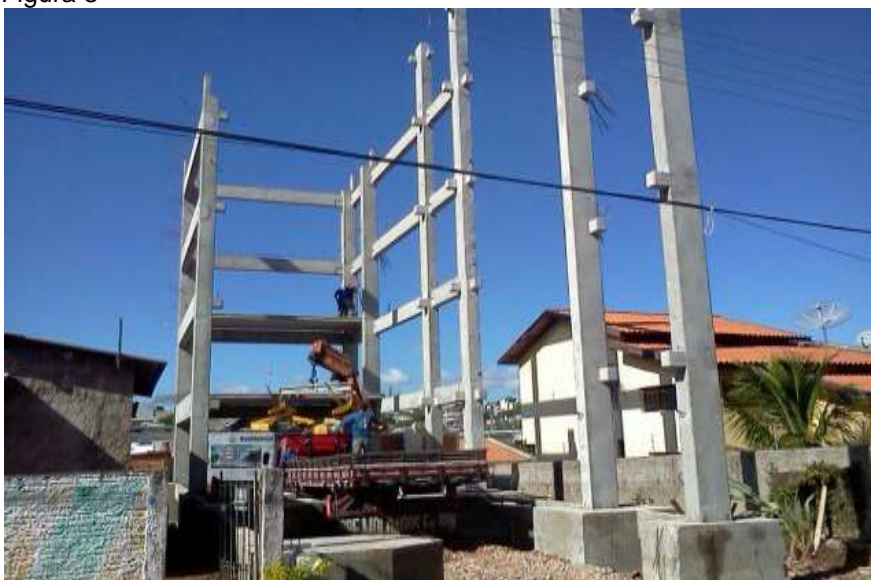
Estrutura da construção do Prédio Flor de Liz. Itararé SP.
