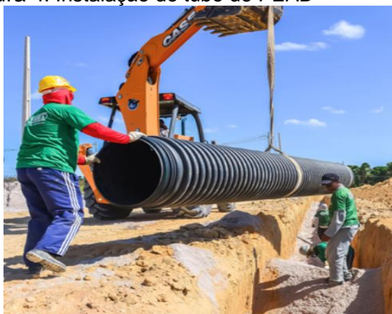
Figura 4. Instalação do tubo de PEAD
