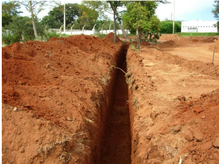
Figura 1. Vala para assentamento de tubos
