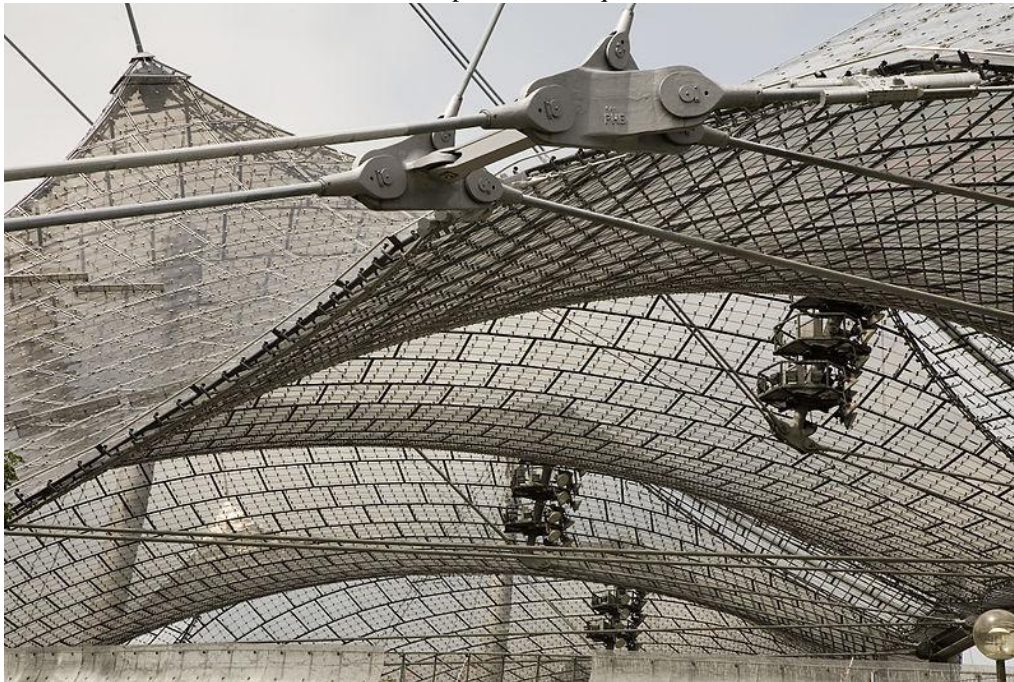
Figura 1 – Estrutura tensionada do estádio olímpico de Munique.
