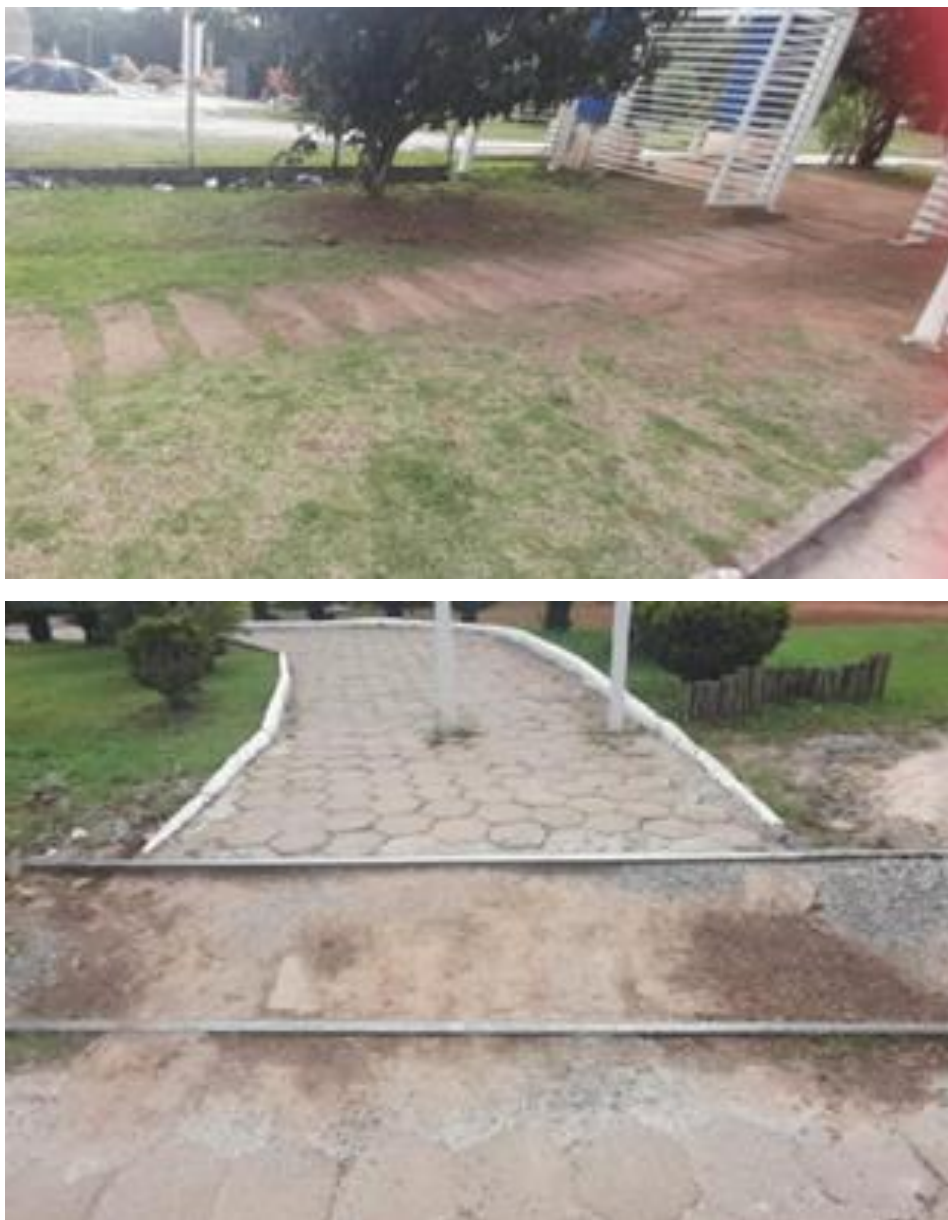
Figura 5: calçada e travessia
