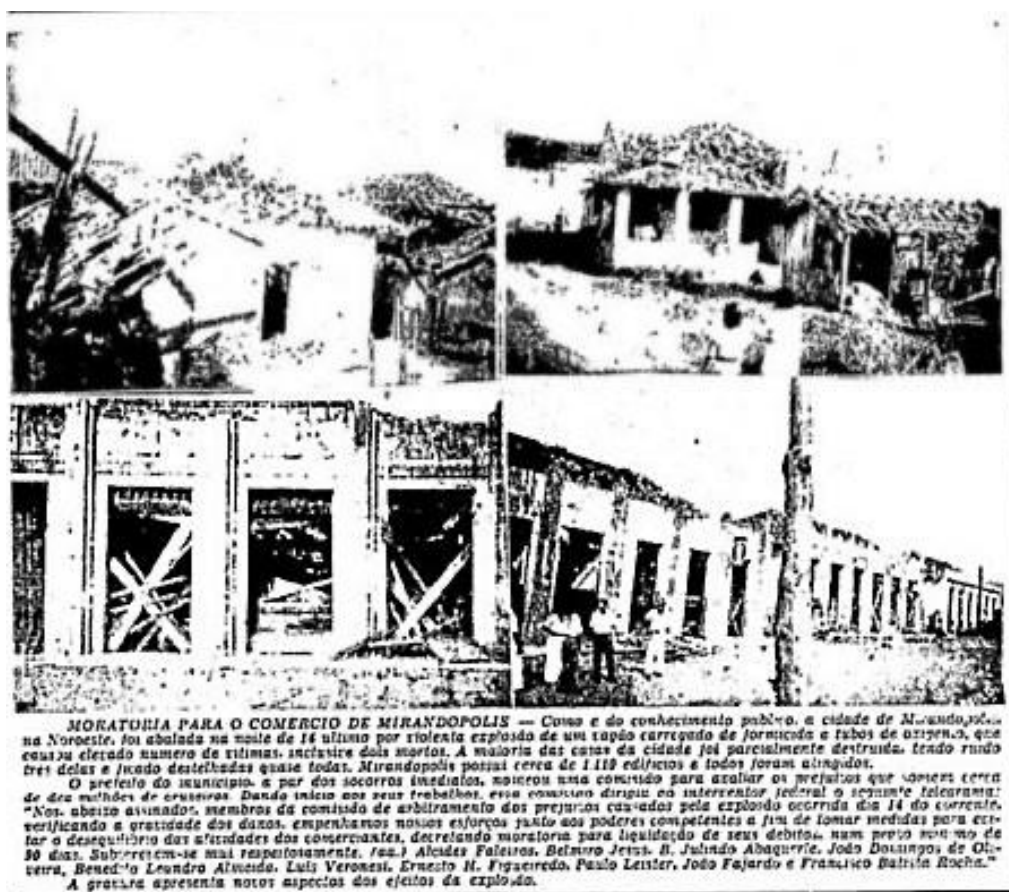
Figura 4 – Entorno da estação ferroviária após explosão
