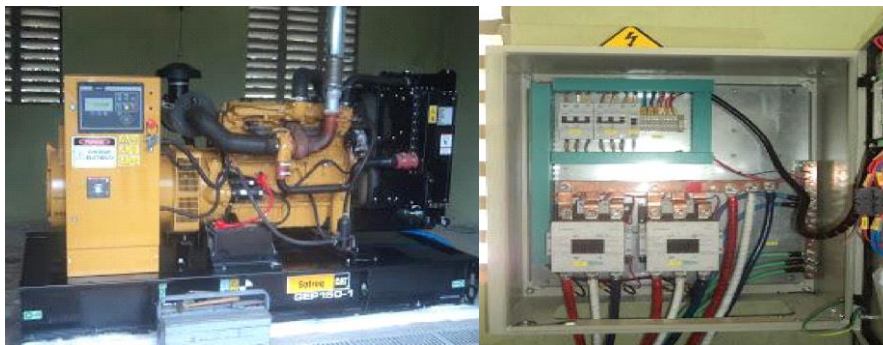
Figura 4 – Quadro de transferência automática do gerador.
