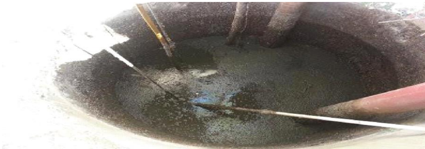
Figura 5 - EEE – Interior do Poço de Sucção
