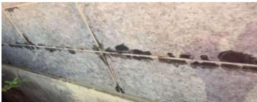
Figura 5 – Imagens da situação atual dos azulejos do mural
