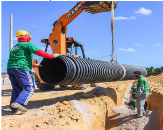
Figura 4. Instalação do tubo de PEAD
