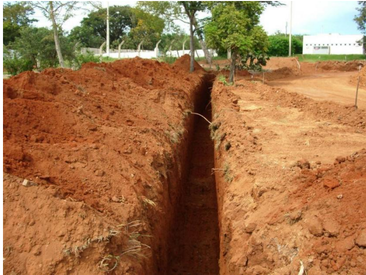
Figura 1. Vala para assentamento de tubos
